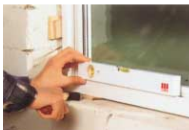
Montáž a vyvážení pomocí dřevěných klínek
