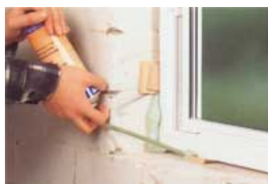
Vyplnění mezer pěnou
