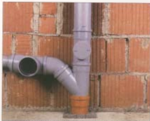
6. označit trubku na hraně hrdla a potom ji asi o 10 mm z hrdla vytáhnout
